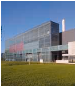
Une usine modernisée et mise aux normes antipollution.
