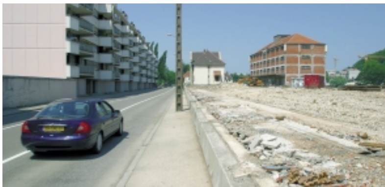
Démolition au programme pour le futur port fluvial.
