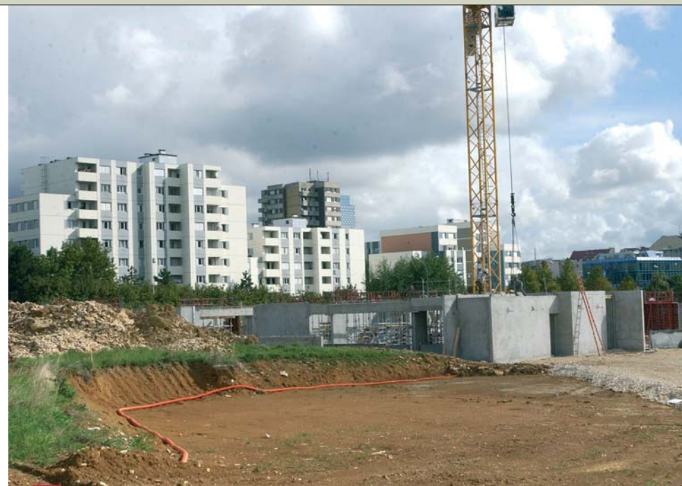
▲ LES NOUVEAUX LOCAUX DE L'IRTS, UN CHANTIER DE QUELQUE 4 000 M 2 .
