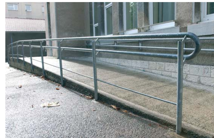
▲ UNE ÉCOLE ÉLÉMENTAIRE (ICI FANART) ET UNE MATERNELLE PAR SECTEUR DISPOSENT D'ACCÈS AMÉNAGÉS POUR LES ÉLÈVES À MOBILITÉ RÉDUITE.
