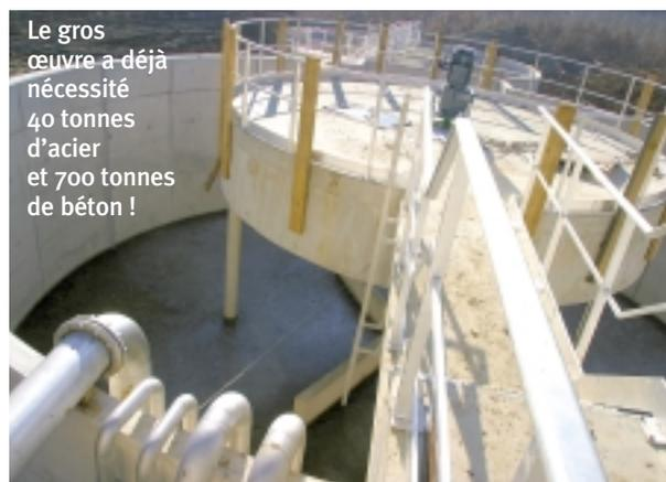
Le gros œuvre a déjà nécessité 40 tonnes d’acier et 700 tonnes de béton !
