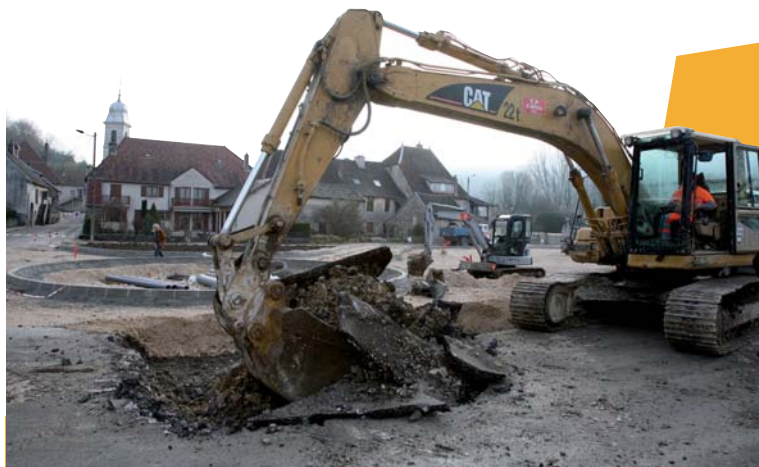
À Avanne Aveney, les travaux vont bon train pour la réalisation d'un parc au bord du Doubs.
