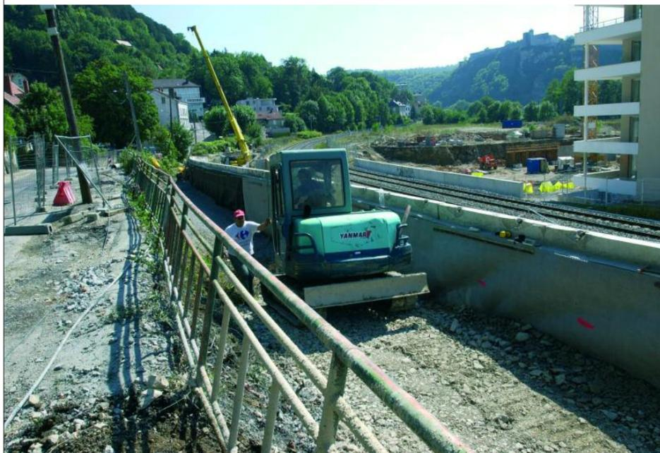
UN MUR DE SOUTÈNEMENT DE 250 M DE LONG A ÉTÉ NÉCESSAIRE.
