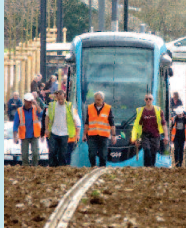
Les derniers travaux du tram et les essais techniques ▲ s'intensifient en mars 2014.
