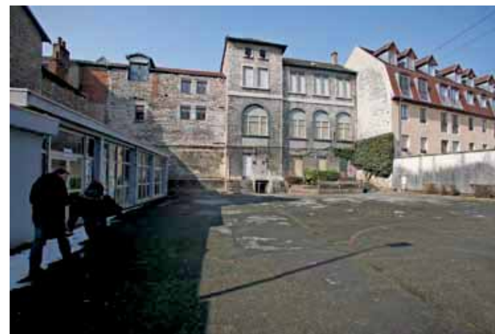
▲ LE 6, RUE DE LA MADELEINE ET LA PLACE D'ARÈNES VONT CONNAÎTRE DE NOUVELLES DESTINATIONS.
