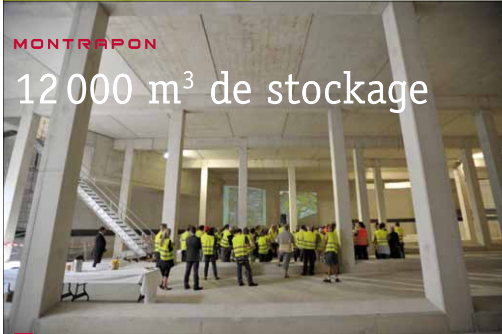
UN OUVRAGE SOUTERRAIN AUX DIMENSIONS IMPRESSIONNANTES.
