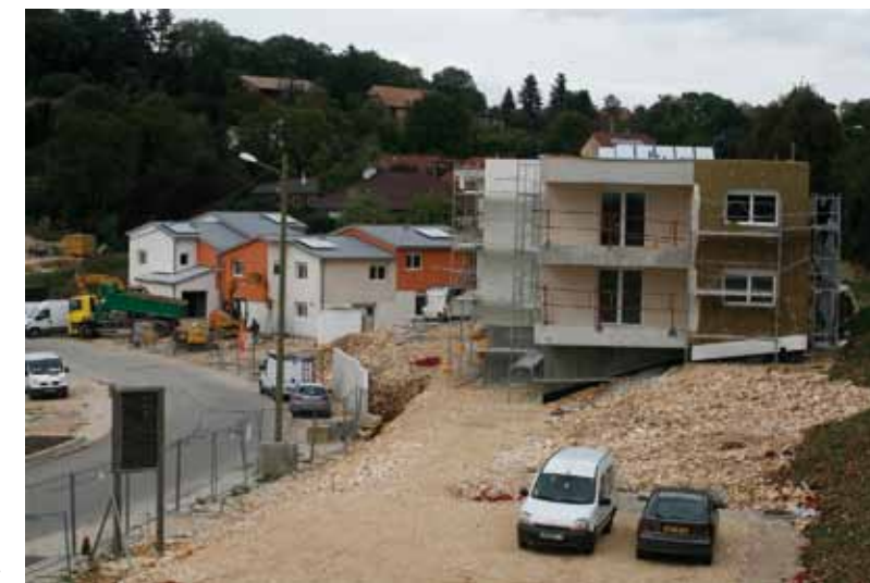
ENCORE QUELQUES SEMAINES DE TRAVAUX AVANT L'INSTALLATION DES PREMIERS LOCATAIRES.
