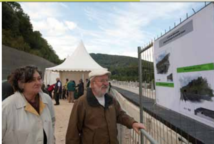
À CHAQUE VISITE, L'AMPLEUR DU CHANTIER IMPRESSIONNE ANDRÉE ET BERNARD, RETRAITÉS DE SAINT-FERJEUX.
