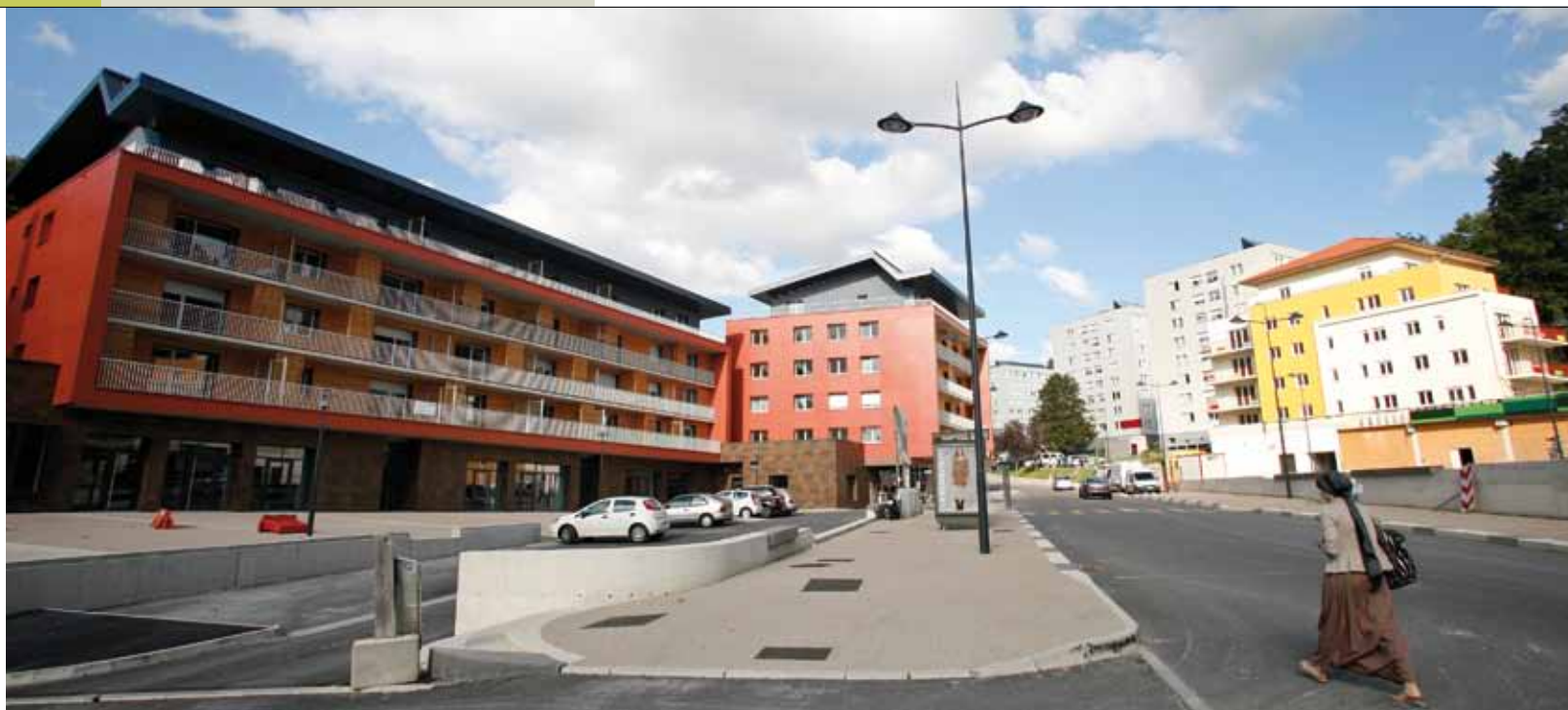
▲ DEUX PROGRAMMES IMMOBILIERS, LES LUMIÈRES DU JOUR (À GAUCHE) ET LES ARCS EN CIEL (À DROITE), DÉLIMITENT LE HAUT DE LA PLACE DES LUMIÈRES.
