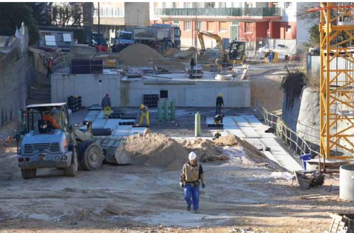
**Avec ses 115 m de long, 15 de large et 3,5 de haut, soit une** capacité de stockage d'environ 5500 m<sup>3</sup> utiles, ce futur bassin de stockage des eaux pluviales en impose. Une fois en service, il permettra de supprimer un certain nombre de déversements
