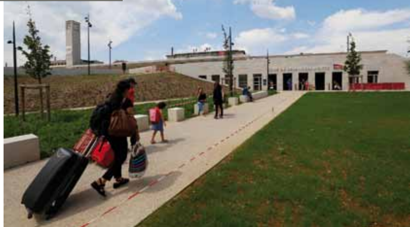
↑ AU CŒUR DU PÔLE D'ÉCHANGE MULTIMODAL, UNE GARE TRAVERSANTE, MODERNE ET ACCESSIBLE À TOUS.
