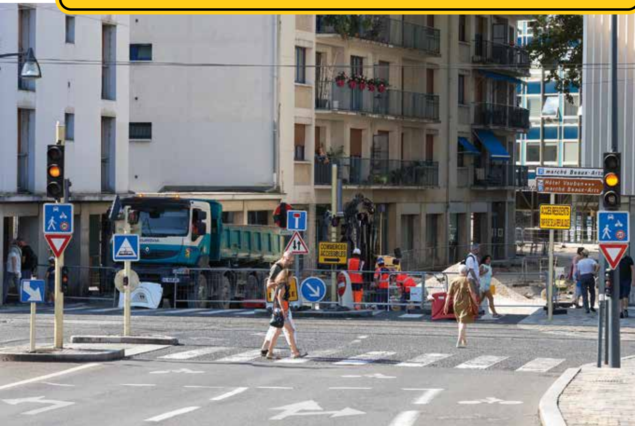
▲ TRAVAUX DE RÉSEAU RUE PROUDHON.
