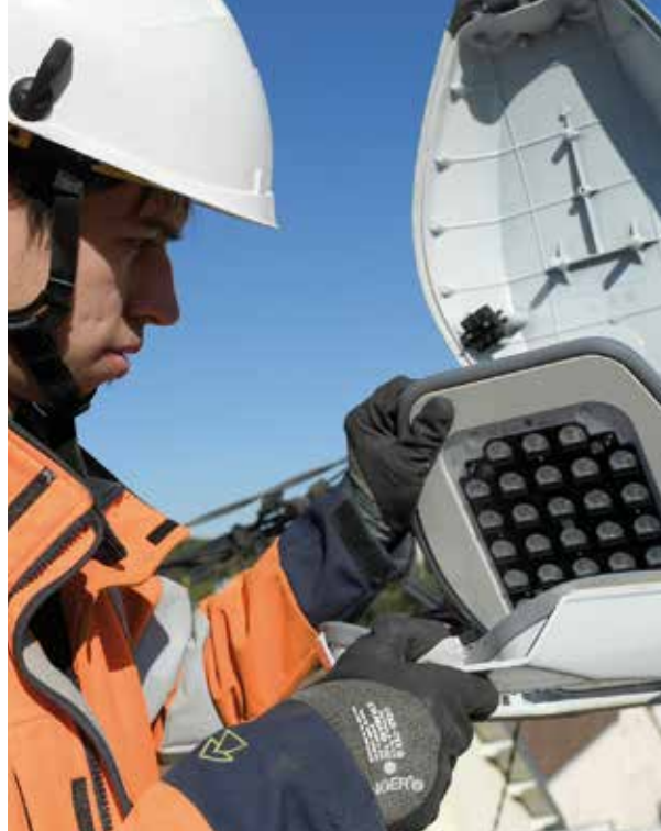
▲ Éclairage public : remplacement des lampes par des leds.
