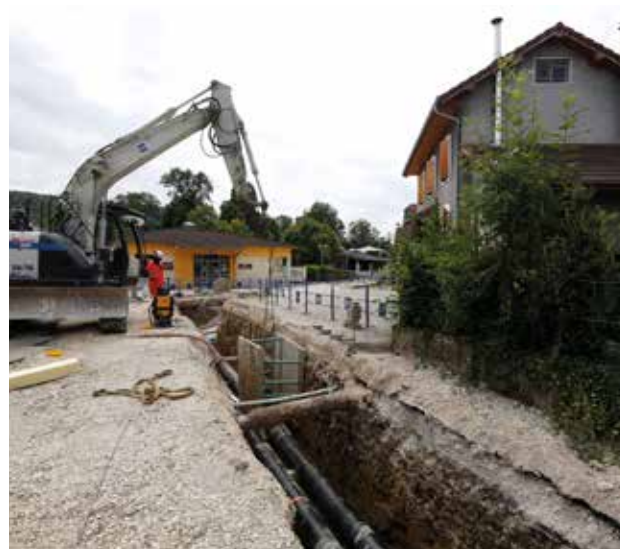
D'impressionnantes tranchées sillonnent les rues principales de Novillars pour installer un réseau de chaleur depuis la papeterie GEMDOUBS.
