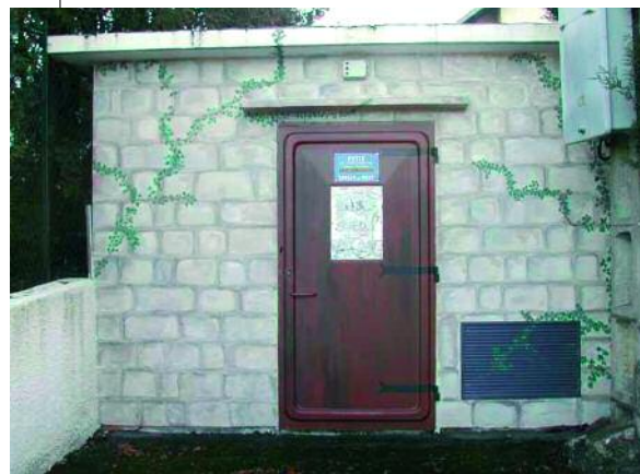
... ET APRÈS LES TRAVAUX DE NETTOYAGE.
