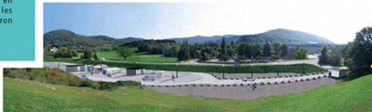
En septembre, la réhabilitation de l'aire de la Malcombe sera terminée
