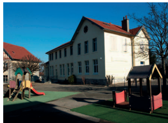
UNE RÉNOVATION RÉUSSI.
