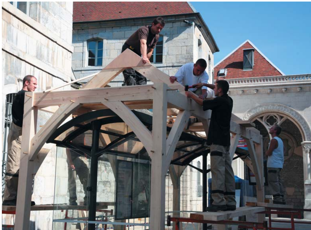
Une structure en bois a été installée place de la Révolution en septembre dernier par des apprentis charpentiers.
