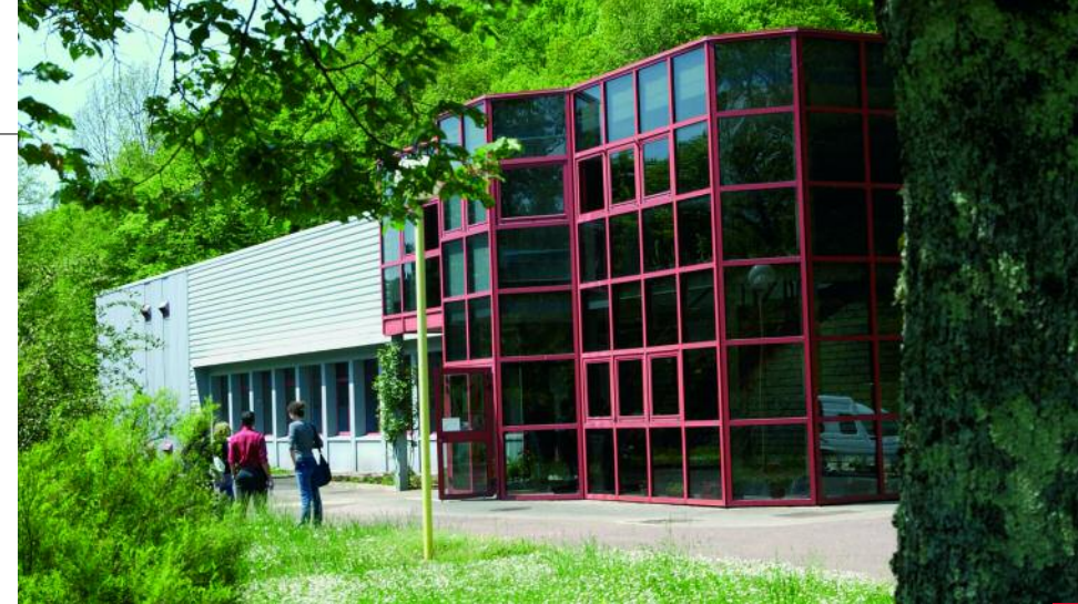
L'USINE DE PRODUCTION D'EAU POTABLE DE CHENECEY BULLON VAUT BIEN UN COURT DÉPLACEMENT.
