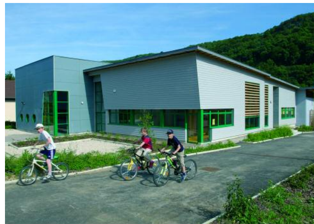
400 M 2 DE LOCAUX NEUFS AU SERVICE DES HABITANTS DU QUARTIER.
