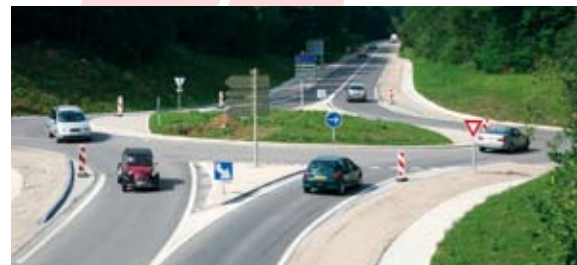
Le nouveau carrefour giratoire à l'entrée de Serre-les-Sapins
