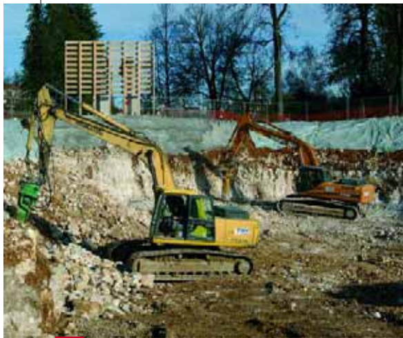
UN CRATÈRE IMPRESSIONNANT POUR ACCUEILLIR LA NOUVELLE CUVE.
