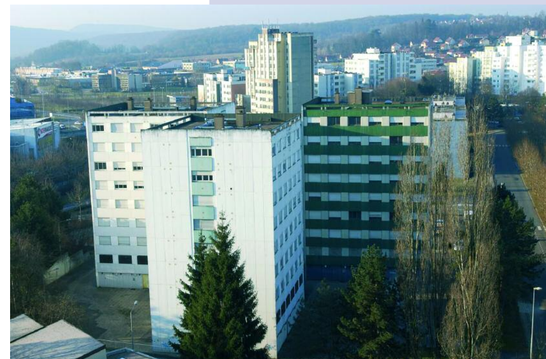
LA DÉCONSTRUCTION DES TROIS TOURS DU « TRIPODE » MARQUE LE LANCEMENT DU PROGRAMME DE RÉNOVATION URBAINE (PRU) DE PLANOISE.
