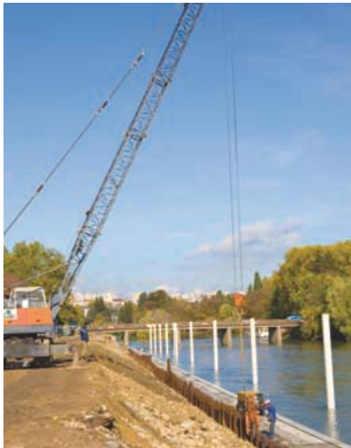
Les travaux pour la future halte du port fluvial de Besançon avancent progressivement.
