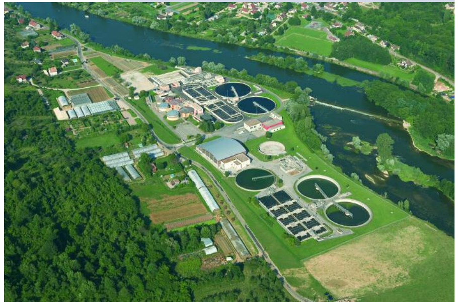
LA STATION D'ÉPURATION DE PORT DOUVOT TRAITE CHAQUE JOUR PLUS DE 30 000 M 3 D'EAUX USÉES ET PLUVIALES.
