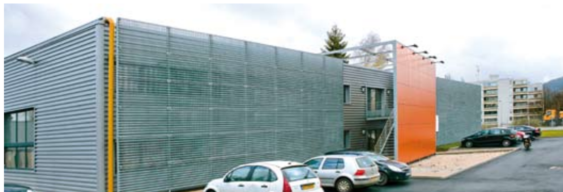
Avec sa verrière photovoltaïque, la reconversion du site répond aux exigences liées au développement durable.
