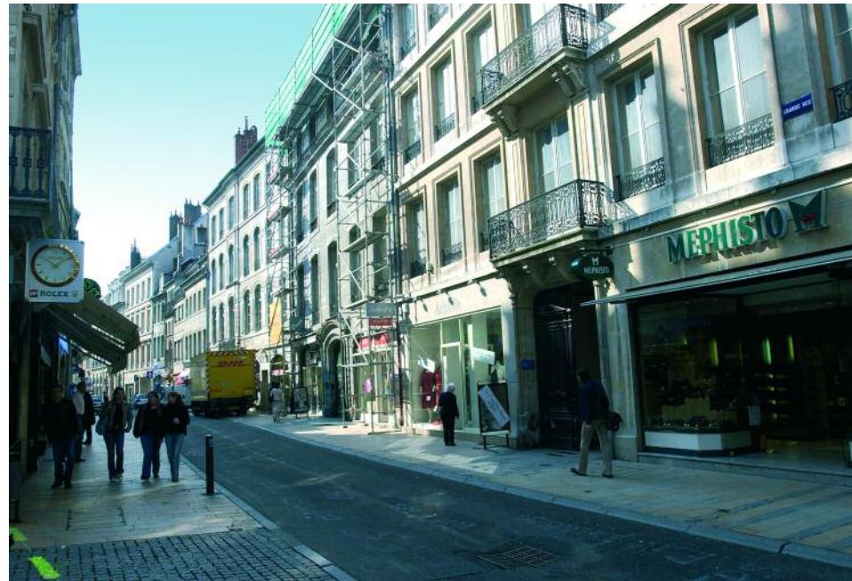
DEUX MOIS DE TRAVAUX SONT INDISPENSABLES.
