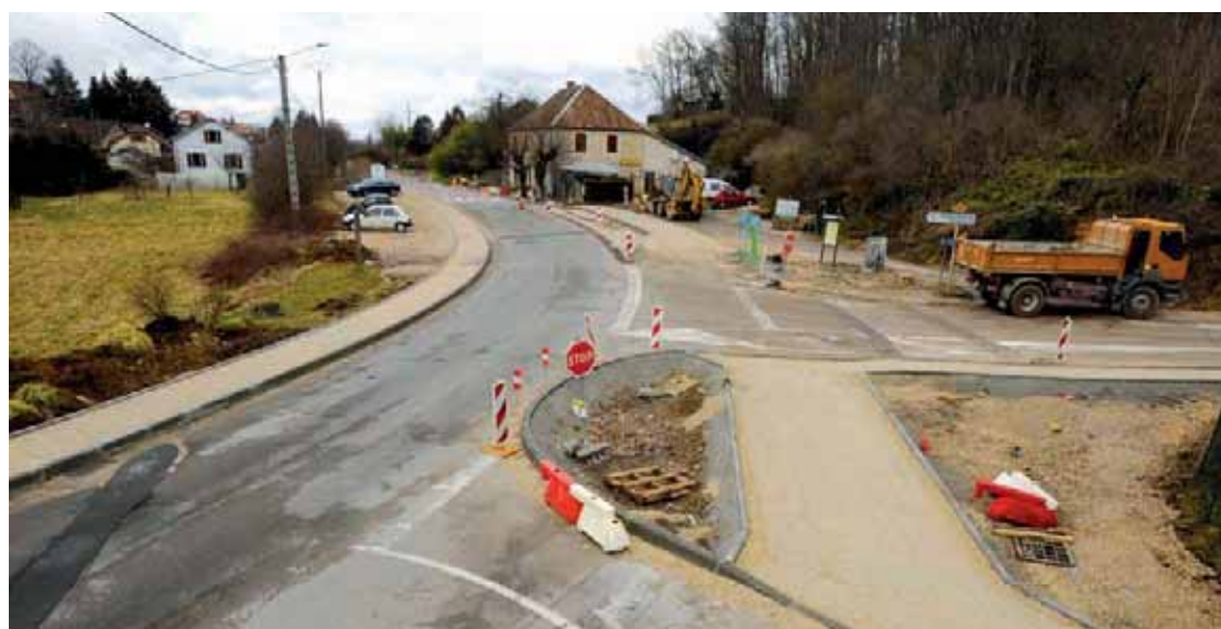
À Montferrand-le-Château, aménagement d'un rond-point.
