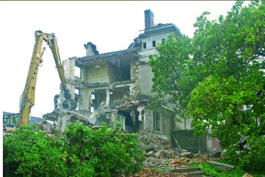
▲ LES DEUX ANCIENS PAVILLONS CÉDERONT LA PLACE EN 2008 À DES LOCAUX FLAMBANT NEUFS.
