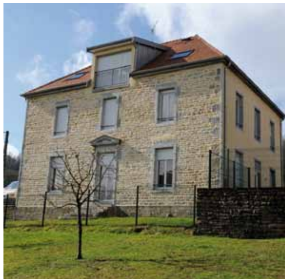
"Les vergers de la cure", ancien atelier municipal et mairie, ce sont quatre logements entièrement rénovés et cofinancés par le Grand Besançon.
