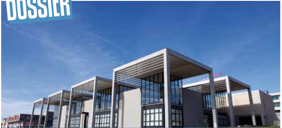
L'UFR de médecine et de pharmacie s'installe progressivement au cœur de Temis Santé dans le quartier des Hauts-de-Chazal.
