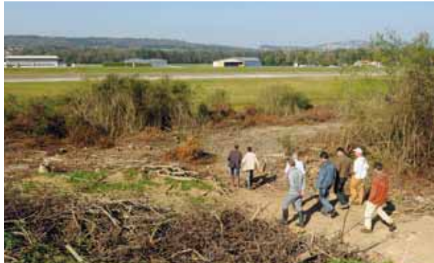
Des travaux de sécurisation ont été menés par des salariés en insertion.
