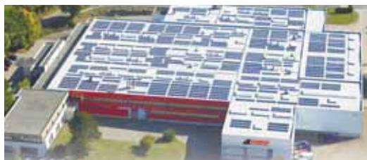
La toiture de Dimeco, avec ses 2700m 2 de panneaux photovoltaïques, est une véritable centrale solaire.
