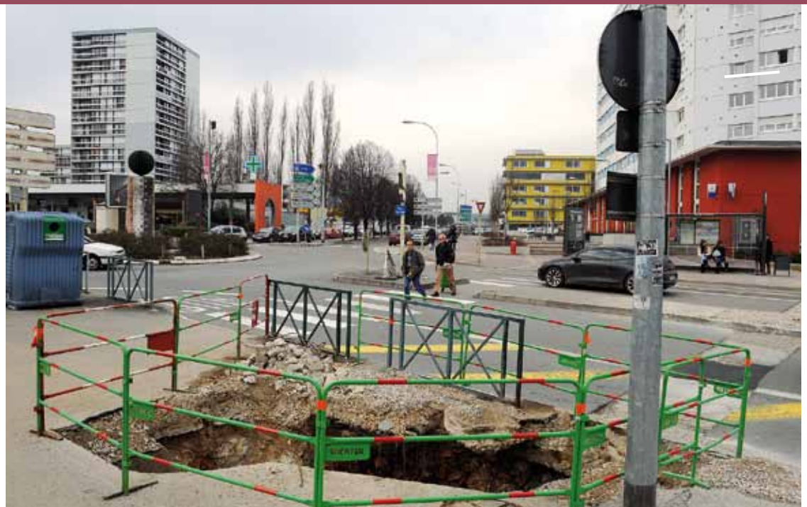
Les travaux de dévoiement des réseaux gaz, électricité, eau... ont maintenant démarré dans la plupart des quartiers concernés par l'arrivée du tramway (ici avenue Île-de-France avec le réseau du gaz).
