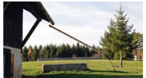
Système de récupération d'eau de pluie à la ferme des Arces au Musée de Nancray.
