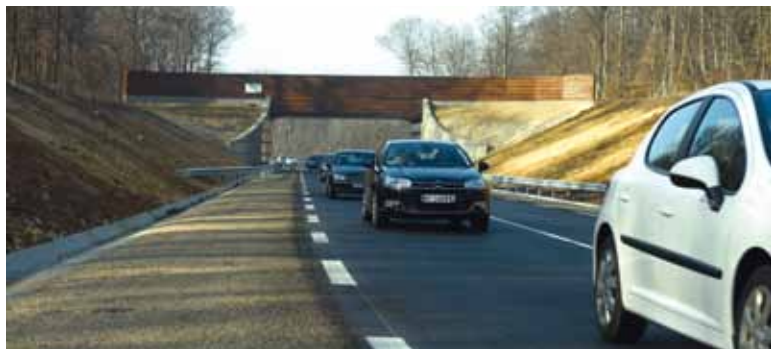
Enrobés tièdes et matériaux recyclés ont été choisis pour la structure de la chaussée, pour une route éco-responsable.
