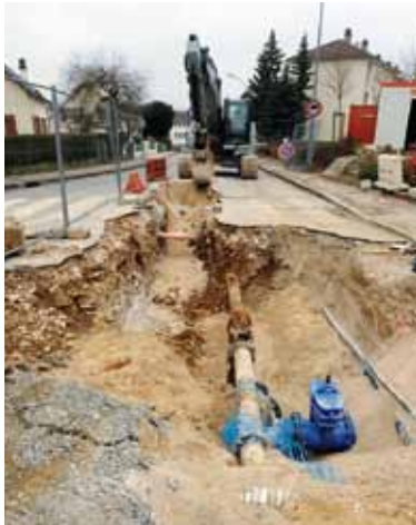
Travaux sur le réseau d'eau, rue des Pâquerettes.
