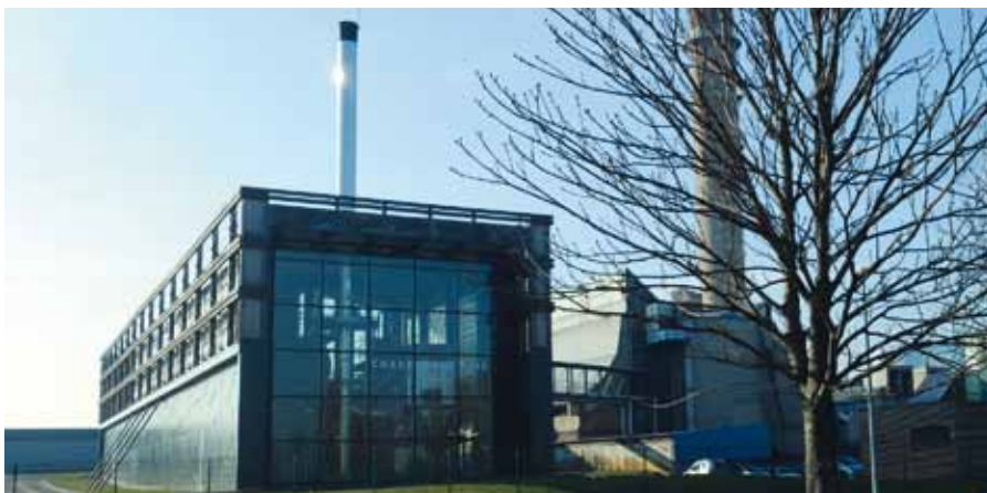
La chaufferie bois à Besançon.
