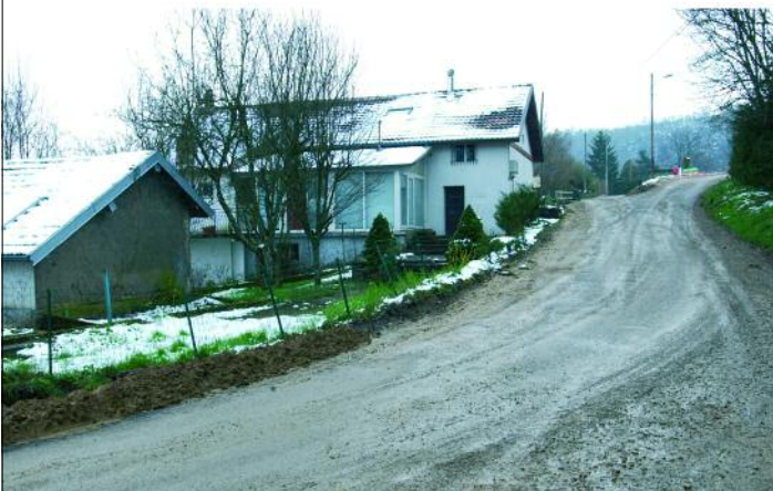
825 M DE CHANTIER POUR 13 BRANCHEMENTS, CHEMIN DE LA JOURANDE.
