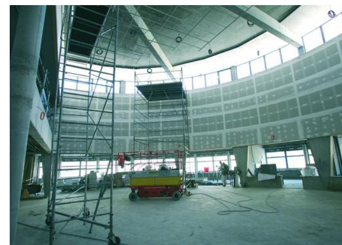
LES TRAVAUX VONT BON TRAIN À L'INTÉRIEUR DU PÔLE.
