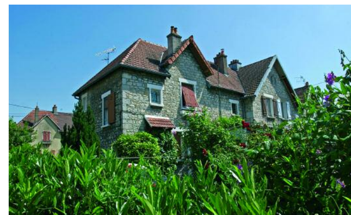
PLUS DE 70 ANS APRÈS SA CONSTRUCTION, LA CITÉ DES COMPTEURS EST TOUJOURS LÀ..
