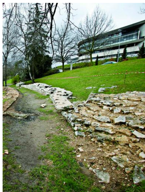
UN TRAVAIL DE RESTAURATION DÉLICAT.
