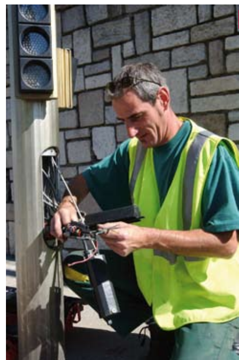
« PETITS » TRAVAUX SUR LA VOIRIE ET...
