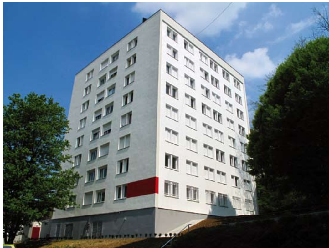
... GRANDE OPÉRATION DE RÉNOVATION URBAINE (AUX CLAIRS-SOLEILS) : DEUX EXEMPLES D'INVESTISSEMENT UTILE.
