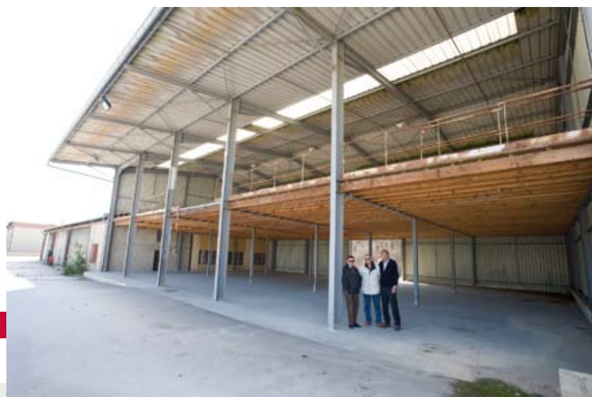
DIRIGÉ PAR CLAUDE RENAUD, LE NOUVEAU CENTRE D'ACCUEIL DE BESANÇON OUVRIRA À LA FIN DU MOIS APRÈS TRAVAUX.
