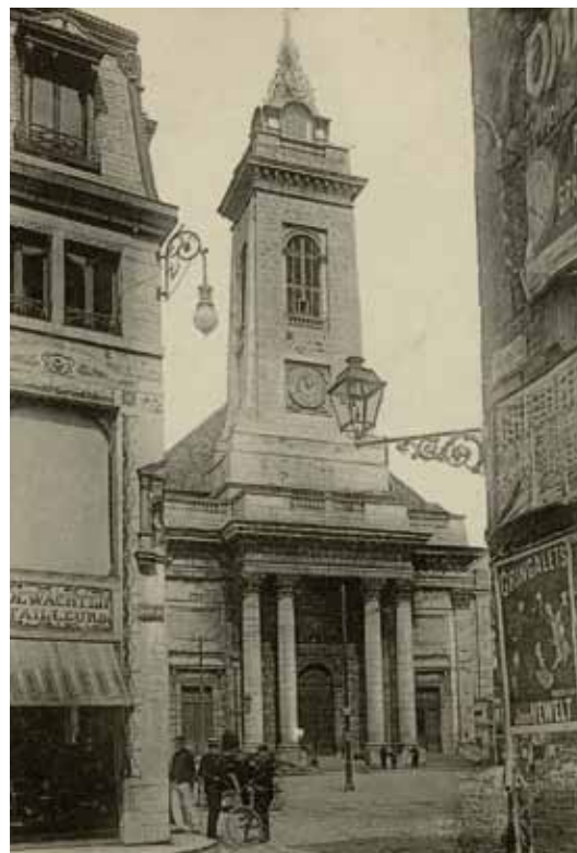
UN MAUVAIS PLAISANTIN, RESTÉ INCONNU, A SÉVI DANS L'ÉGLISE SAINT-PIERRE.
