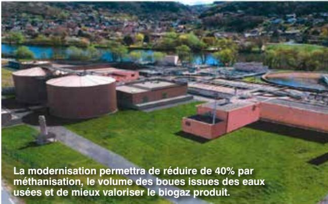
La modernisation permettra de réduire de 40% par méthanisation, le volume des boues issues des eaux usées et de mieux valoriser le biogaz produit.
