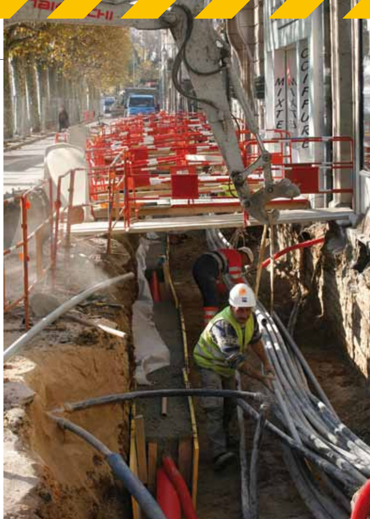
▲ TOUTE LA COMPLEXITÉ DU CHANTIER DU QUAI VEIL-PICARD RÉSUMÉE EN UNE SEULE PHOTO.
