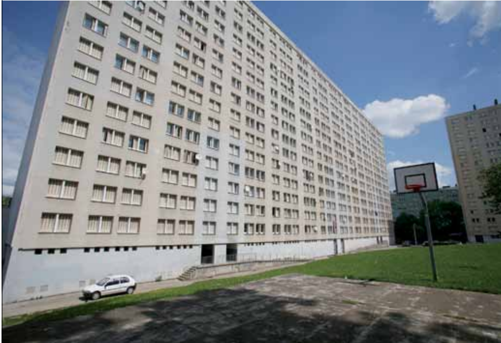
AVANT LA DÉCONSTRUCTION, LA COLLECTE DES TÉMOIGNAGES ET DES SOUVENIRS.
