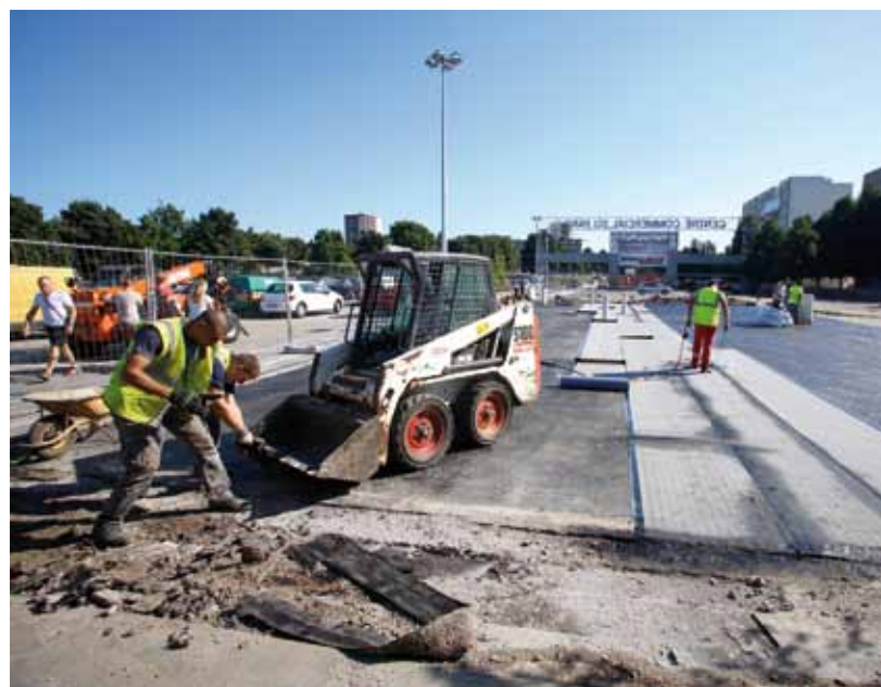
↑ UN CHANTIER DE RÉNOVATION INDISPENSABLE.
