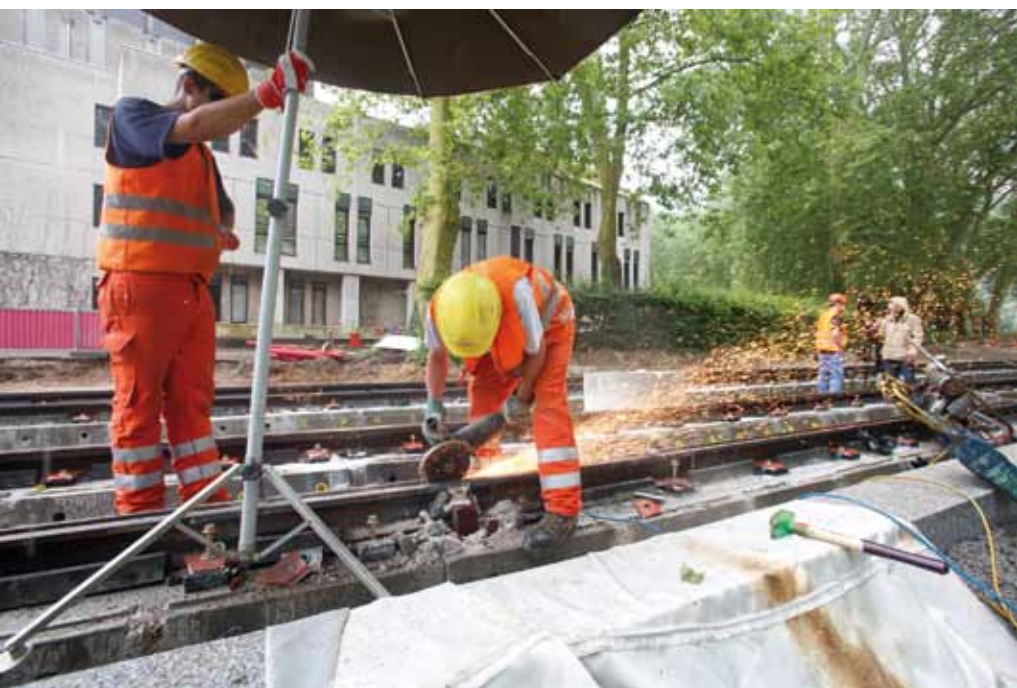
↑ DERNIÈRES ÉTINCELLES À CHAMARS POUR LE TRACÉ OUEST.
