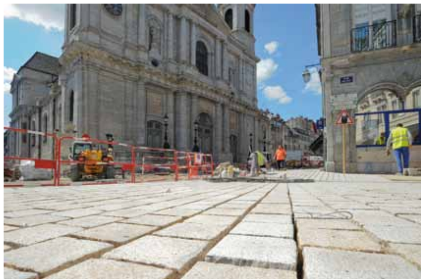
↑ PAVÉ APRÈS PAVÉ, LE FUTUR PARVIS DE LA MADELEINE OCCUPE L'ESPACE.
