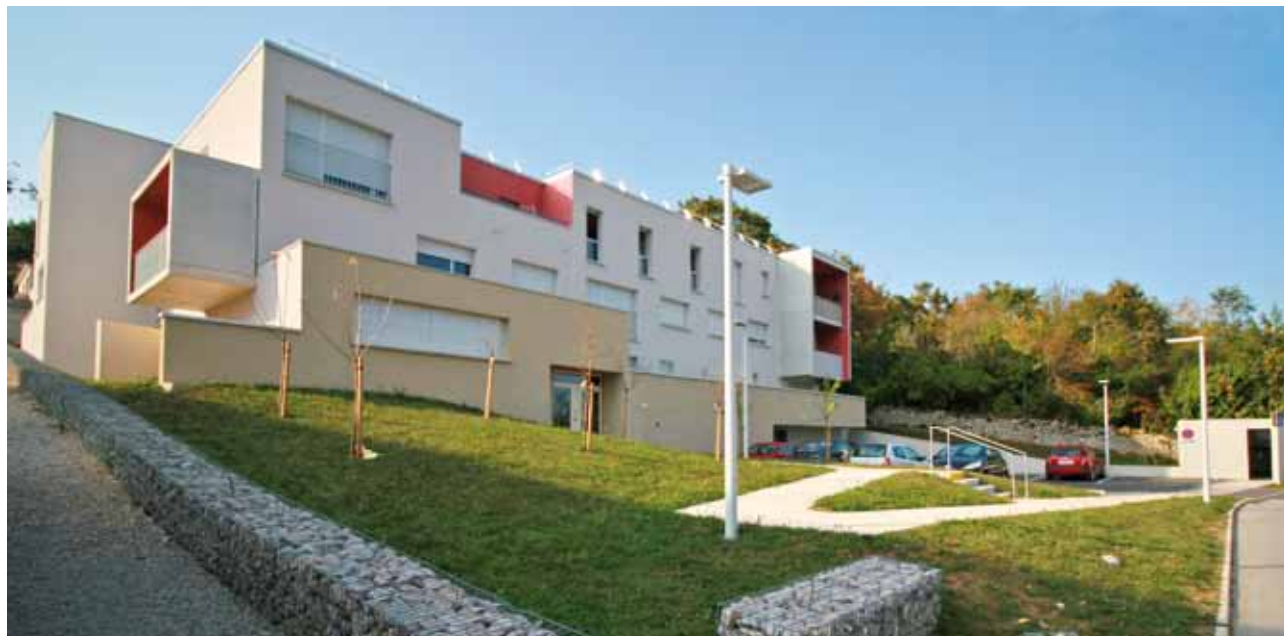
DEUX BÂTIMENTS NOUVEAUX SONT SORTIS DE TERRE À L'ÉTÉ. ▲
