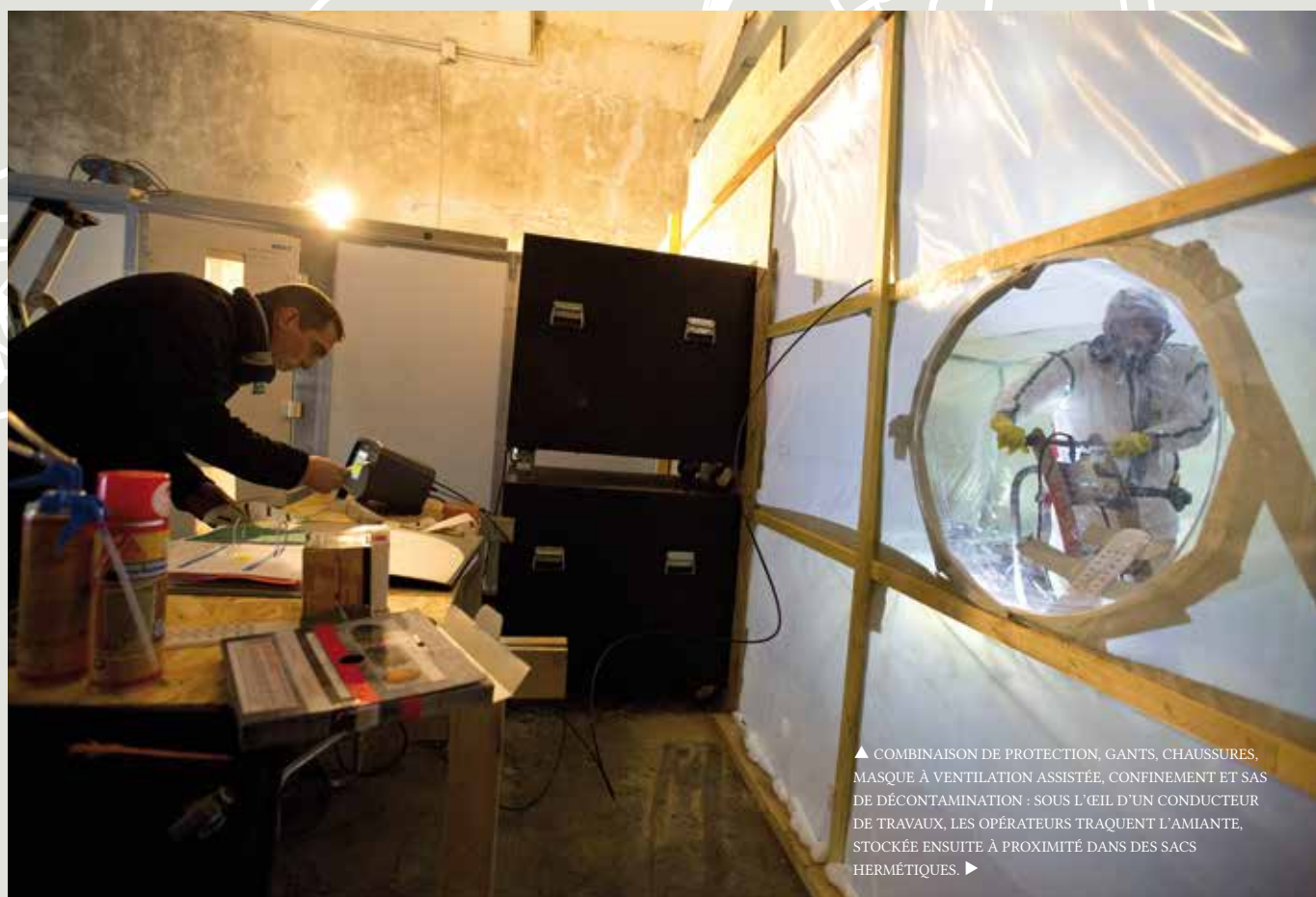
▲ LE CHANTIER DE DÉMOLITION REPRÉSENTE 25 000 M 3 DE MATÉRIAUX DIVERS À ÉVACUER.
