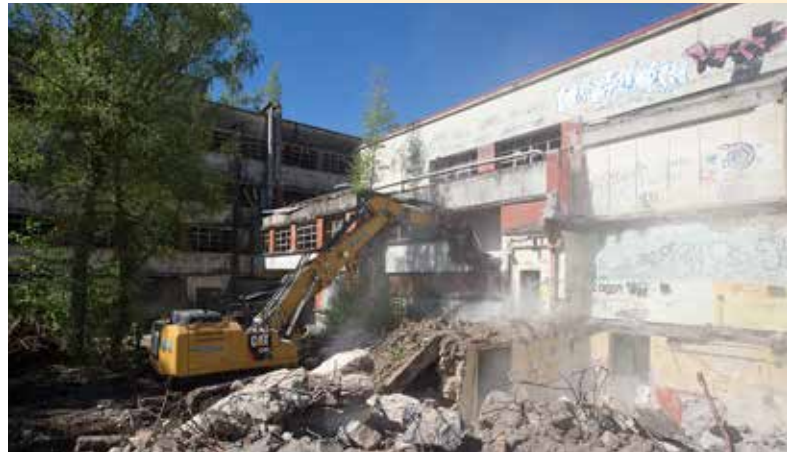
JANVIER 2018 : DÉMOLITION, DÉSAMIANTAGE, DÉCONSTRUCTION... LA RHODIA VIT SES DERNIERS INSTANTS. ▼
