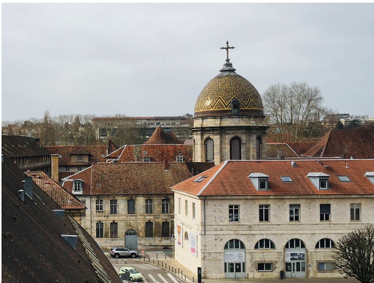
Photo du dôme de la chapelle du Refuge
