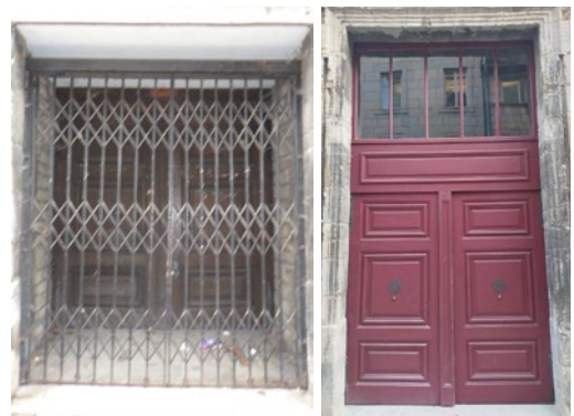
La porte avant travaux et après rénovation
