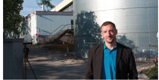
Une des deux cuves d'eaux récupérées - mai 2026
