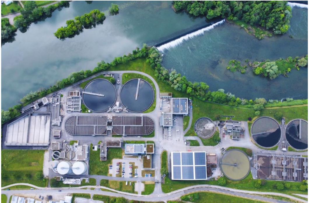
Station d'épuration de Port-Douvot – mars 2026
