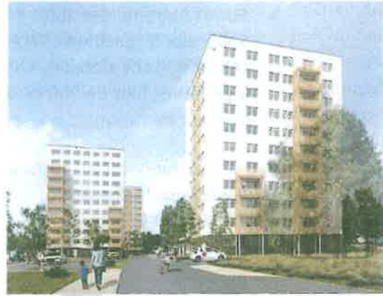
Besançon Tours de l'Amitié 131 logements en cours de réhabilitation Livraison octobre 2024
